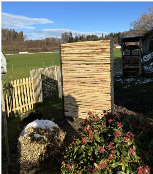
U-Profile aus Coulissenstahl 45/45/3.5mm mit Kastanienstaketen befüllt.
